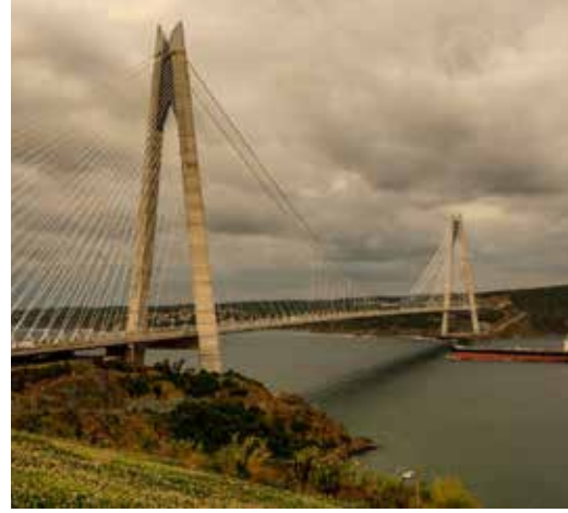
YAVUZ SULTAN SELİM KÖPRÜSÜ İNŞAASI YAVUZ SULTAN SELİM BRIDGE PROJECT
